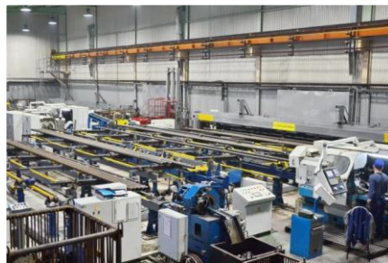
Ремонт глубинно-насосного оборудования (НКТ, ШН и ШГН)
