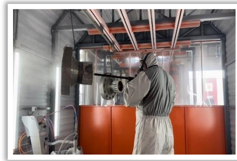
Антикоррозийное полимерное покрытие деталей и узлов трубопровода
